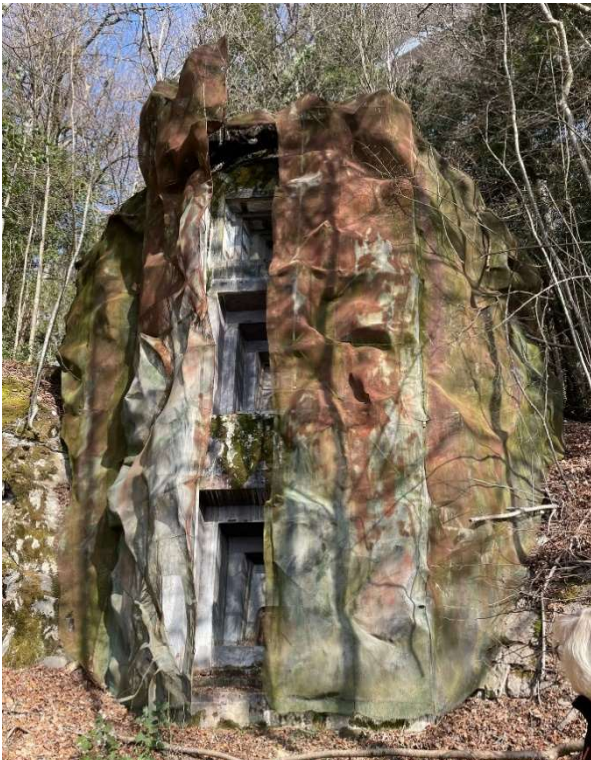
Casemate C8 – vue depuis l'extérieur
