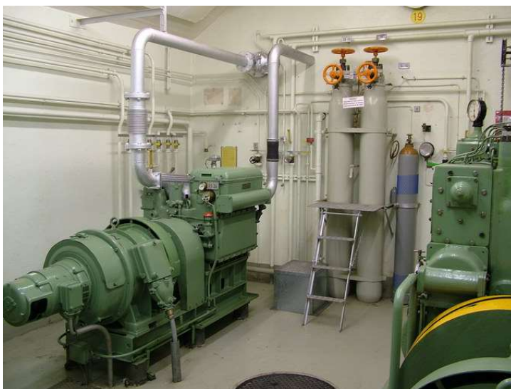
Moteurs Sulzer diesel de la CGN et génératrices Brown Boveri
